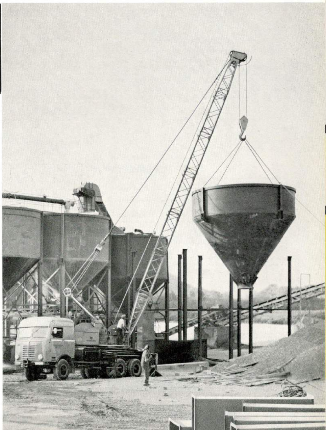
Aufbaukran Auk 40 bei der Montage von Kiesbehältern
