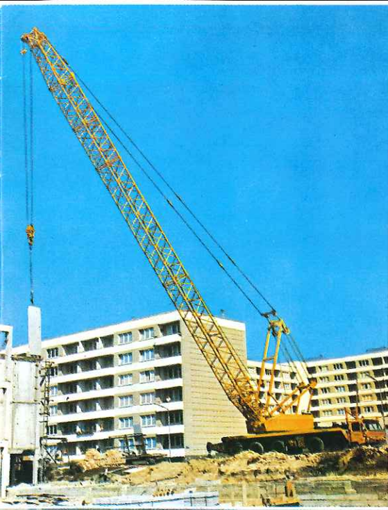
Der Autokran LG 1125 beim Verlegen von Fertigteilen.
