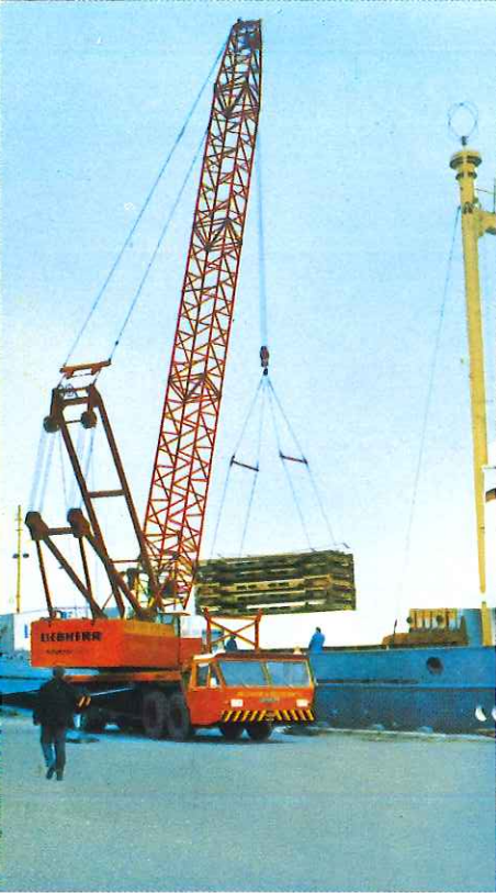
Der Autokran LG 1125 beim Verladen von Eisenschwellen im Hafen von Kopenhagen.
