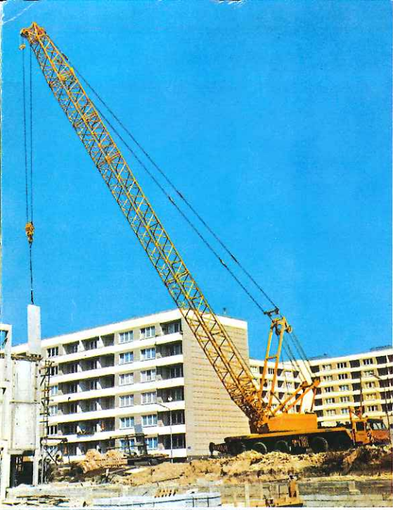
Der Autokran LG 1125 beim Verlegen von Fertigteilen.
