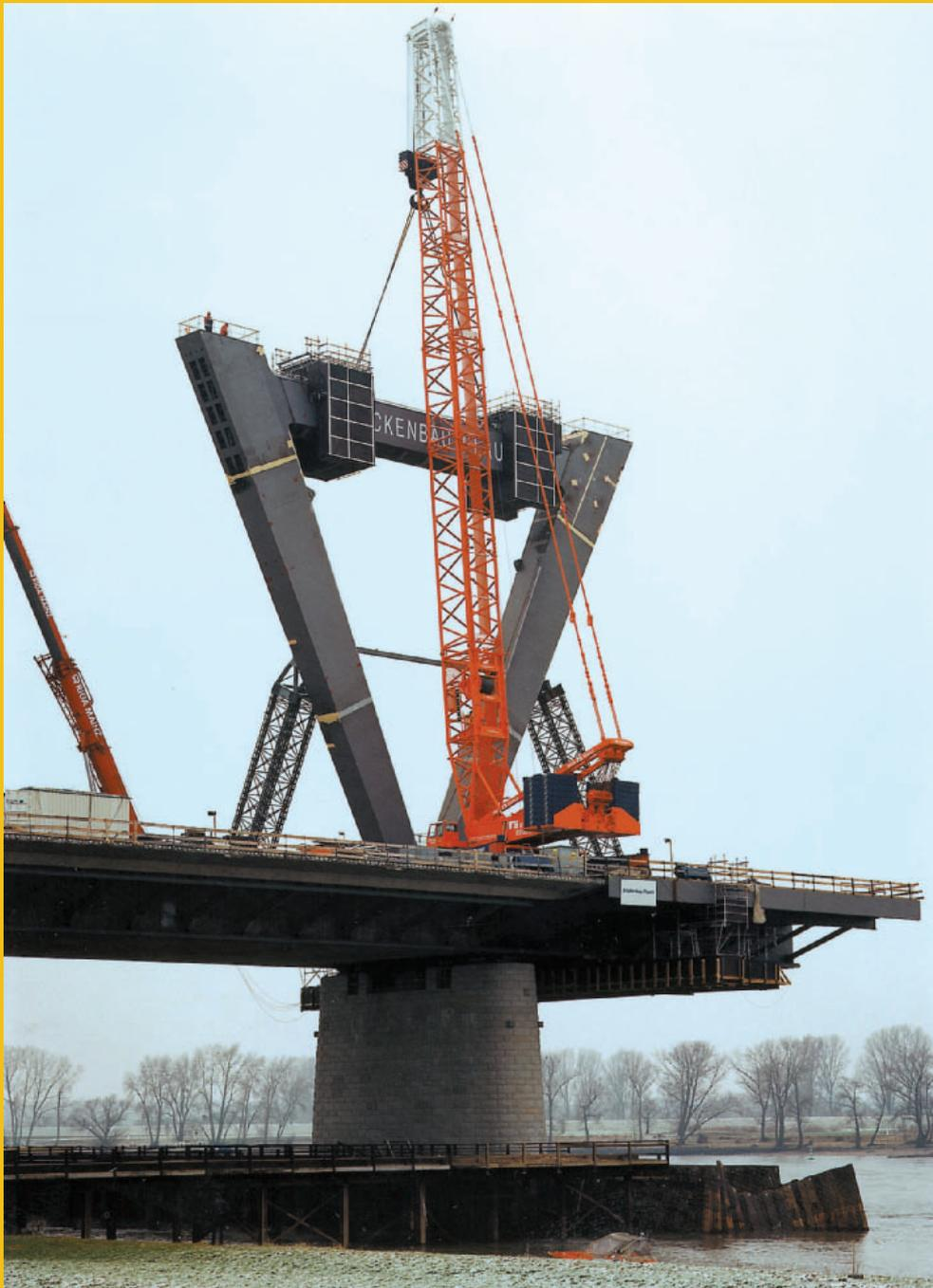
Die Großbaustelle „Rheinquerung A44“ im Norden von Düsseldorf war das erste Ziel des von Liebherr neu entwickelten Raupenkran LR 1600/1 in der Version als „Pedestal Crane“. Beim Setzen von Pylonen auf den Vorlandbrücken wurden die Vorzüge der neuen Technik sichtbar: „Mit Raupen hätte der Kran dort nicht arbeiten können, weil ein exaktes Abstü-
