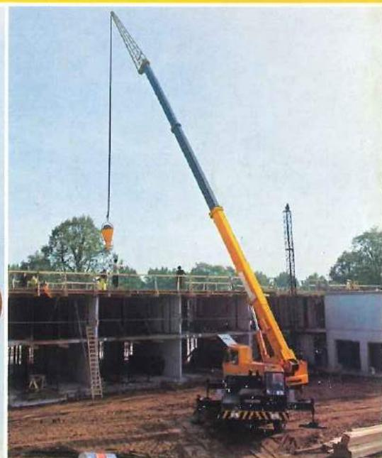
33 m Hubhöhe sind in dieser Kranklasse keine Selbstverständlichkeit. Der LT 1020 hat für diese Höhe die 9 m lange starre Gitterspitze. Sie ist schnell montiert und mit dem Hilfshubwerk kann im 2-Haken-Betrieb gefahren werden.
