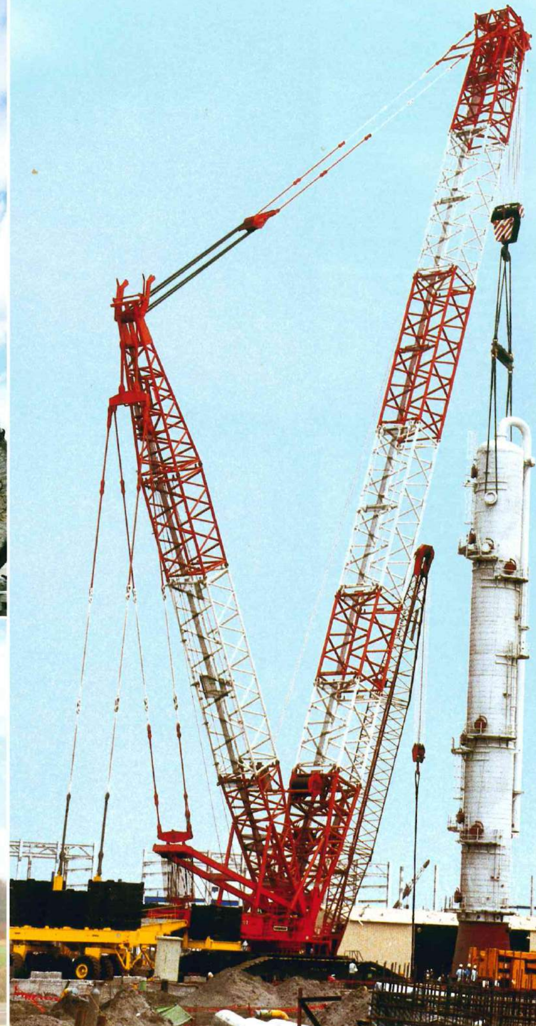
LR 1650 mit SDBW-Ausrüstung
