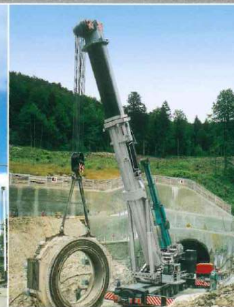
Umsetzen des Bohrkopfes einer Tunnelbohrmaschine.
