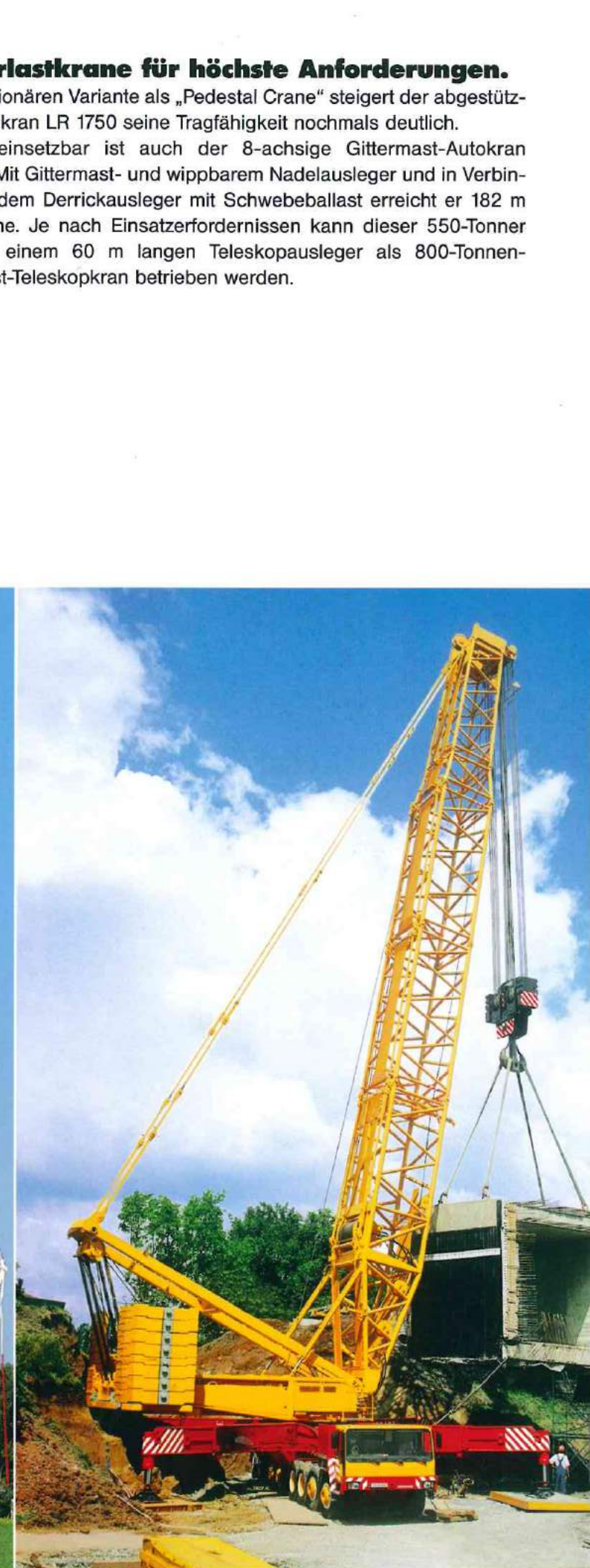
Einheben einer 270 t schweren Unterführung.
