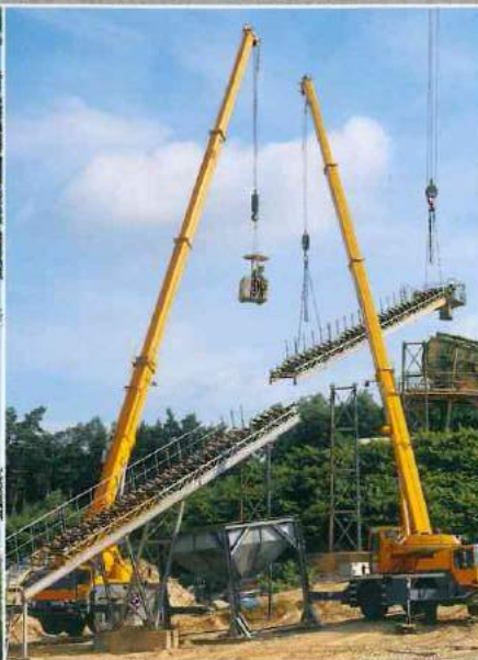
Zusammenbau einer Förderbandanlage.
