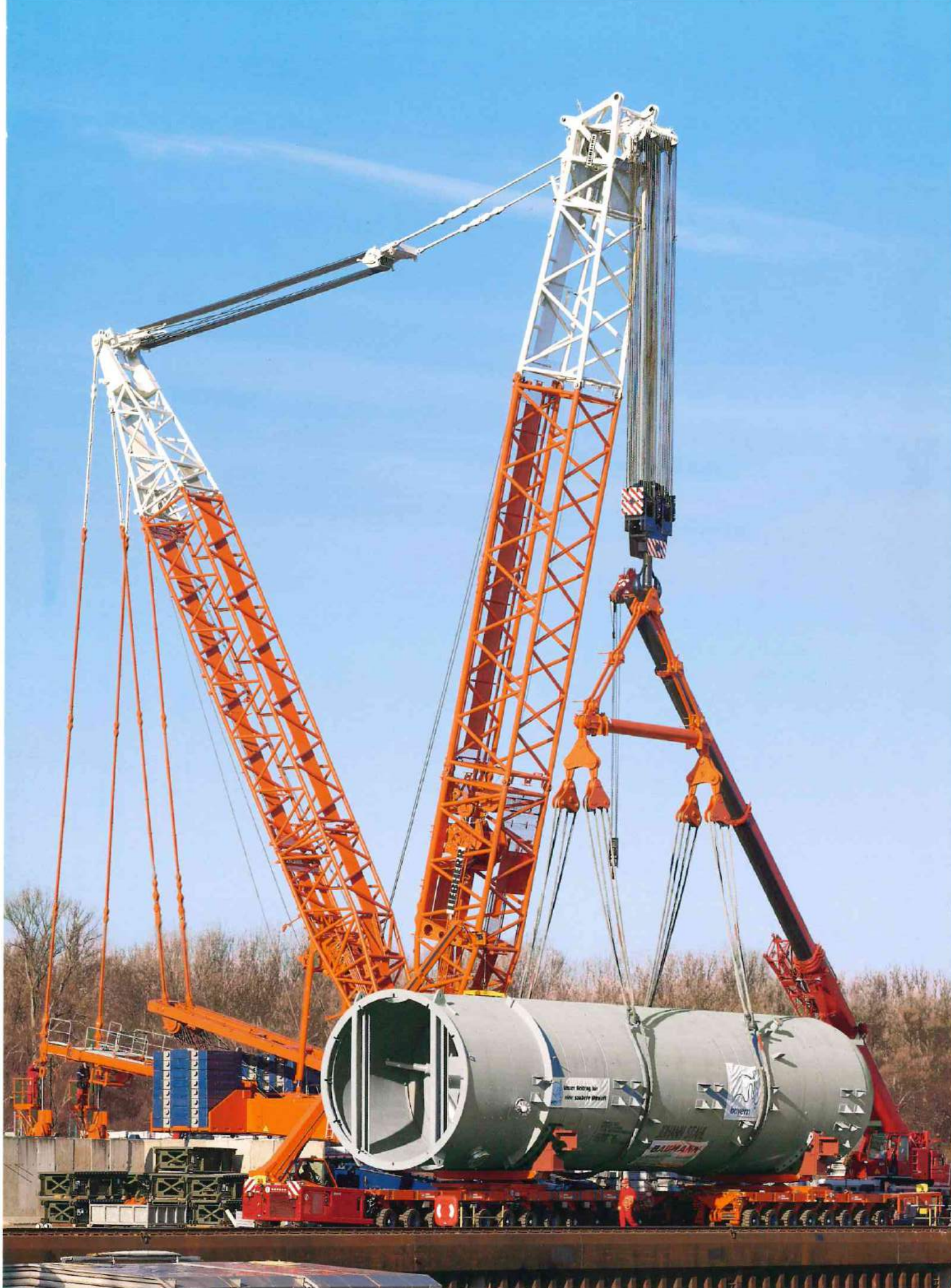
Verladen eines 450 t schweren Reaktors auf einen Selbstfahrer.
