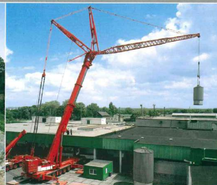
Ausheben eines Tanks.
