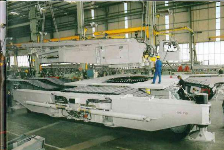
Aufsetzen einer Drehbühne auf Raupenfahrwerk.
