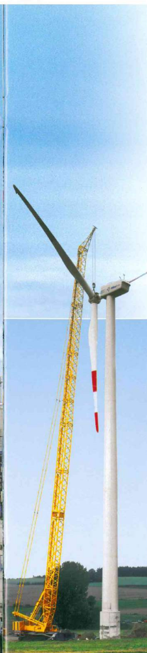
Aufbau einer 100 m hohen Windkraftanlage.
