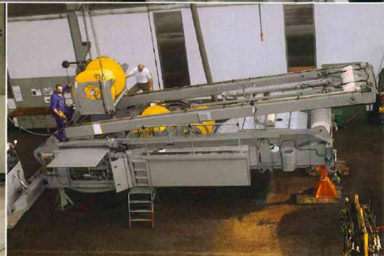
Windeneinbau in Raupenkran-Drehbühne.
