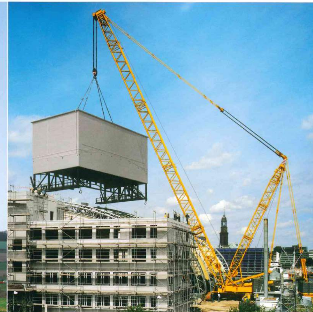
Einheben eines 115 t schweren Bühnenturms.
