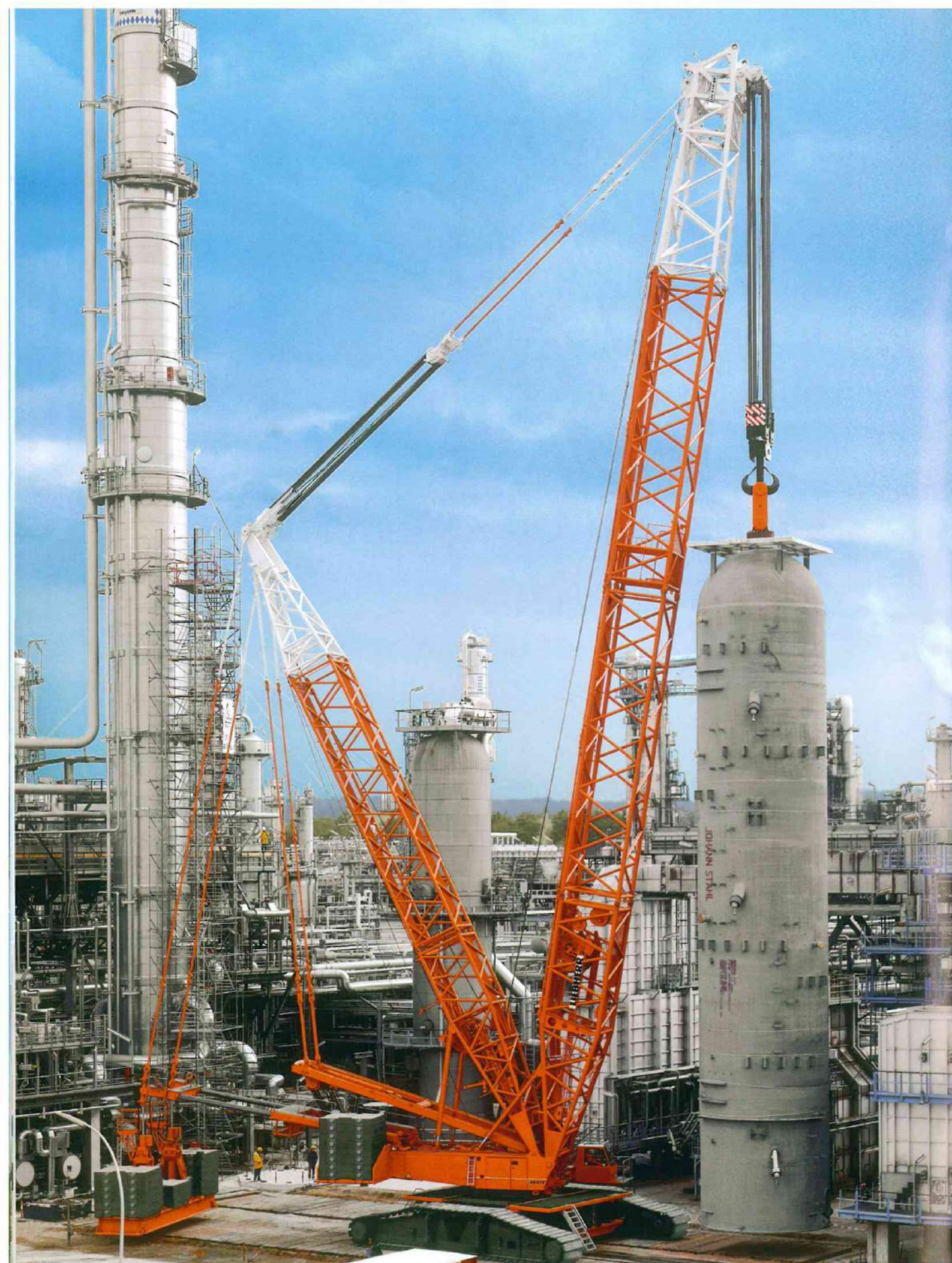
Montage eines 450 t schweren Reaktors.
