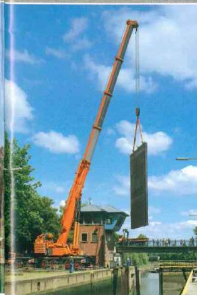
Einheben von Schleusentoren.
