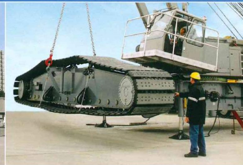
Selbstmontage eines Raupenträgers.
