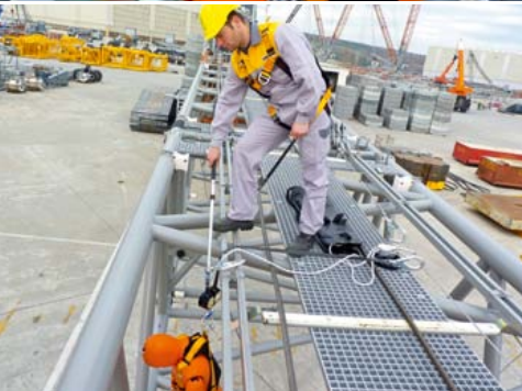
Einhängen des Karabiners mit Hilfe einer Teleskopstange
