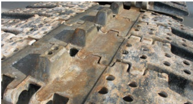
Bodenplatten mit Abnutzung
