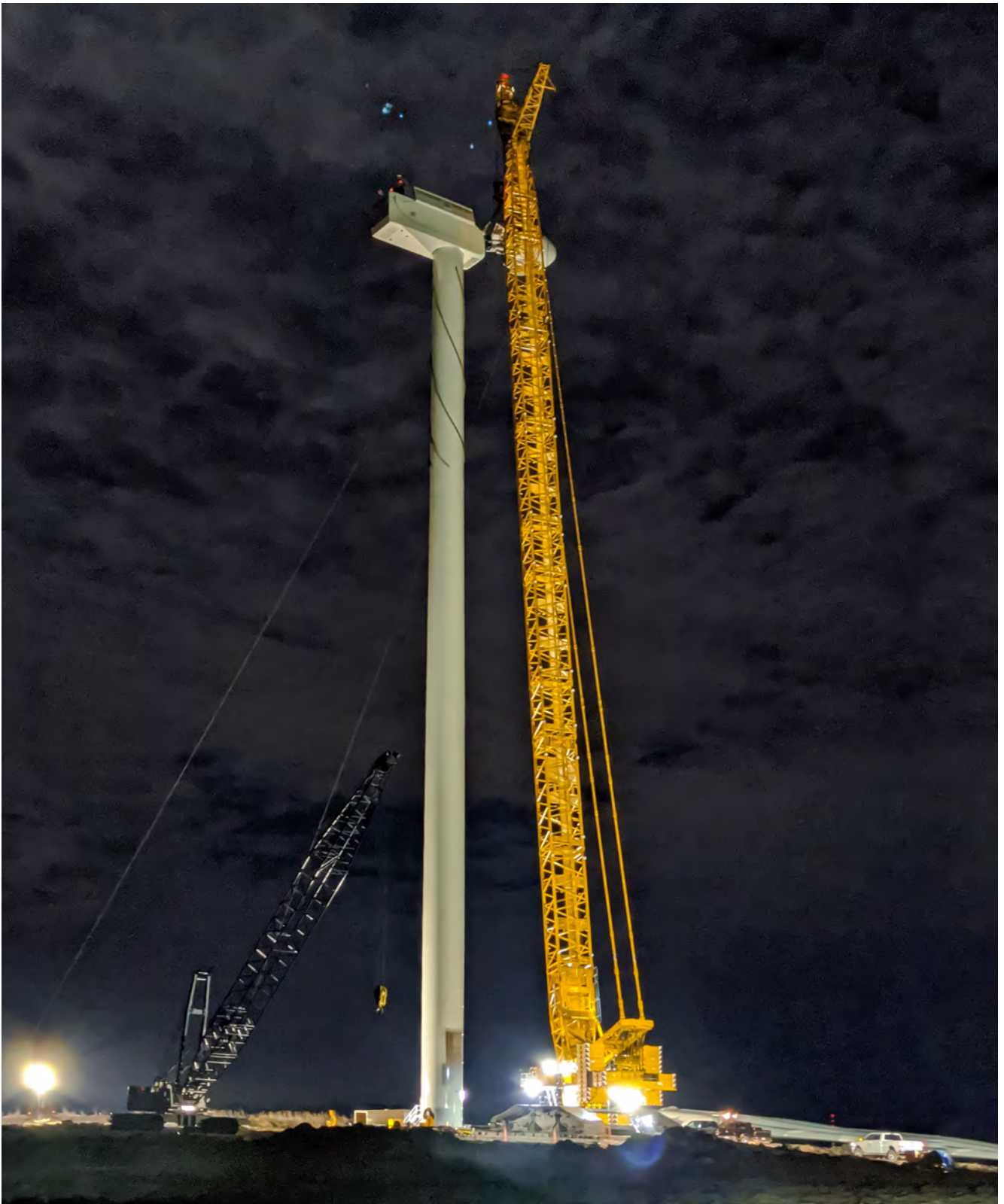
Der Liebherr Raupenkran LR 11000 hat viele Gesichter: Mit Derricksystem für Schwerlasthübe oder schlankem Hauptausleger für die Windkraft. Auf Anregung und zusammen mit dem amerikanischen Kranunternehmen Buckner haben wir das Auslegersystem SL8F2 mit einer komplett neuen festen Spitze speziell für Windkräfteinsetze entwickelt. Inzwischen haben auch andere Kranbetreiber geordert – hier auf dem Bild montiert das US-Unternehmen Northern Construction Windkraftanlagen mit dem neuen System.
