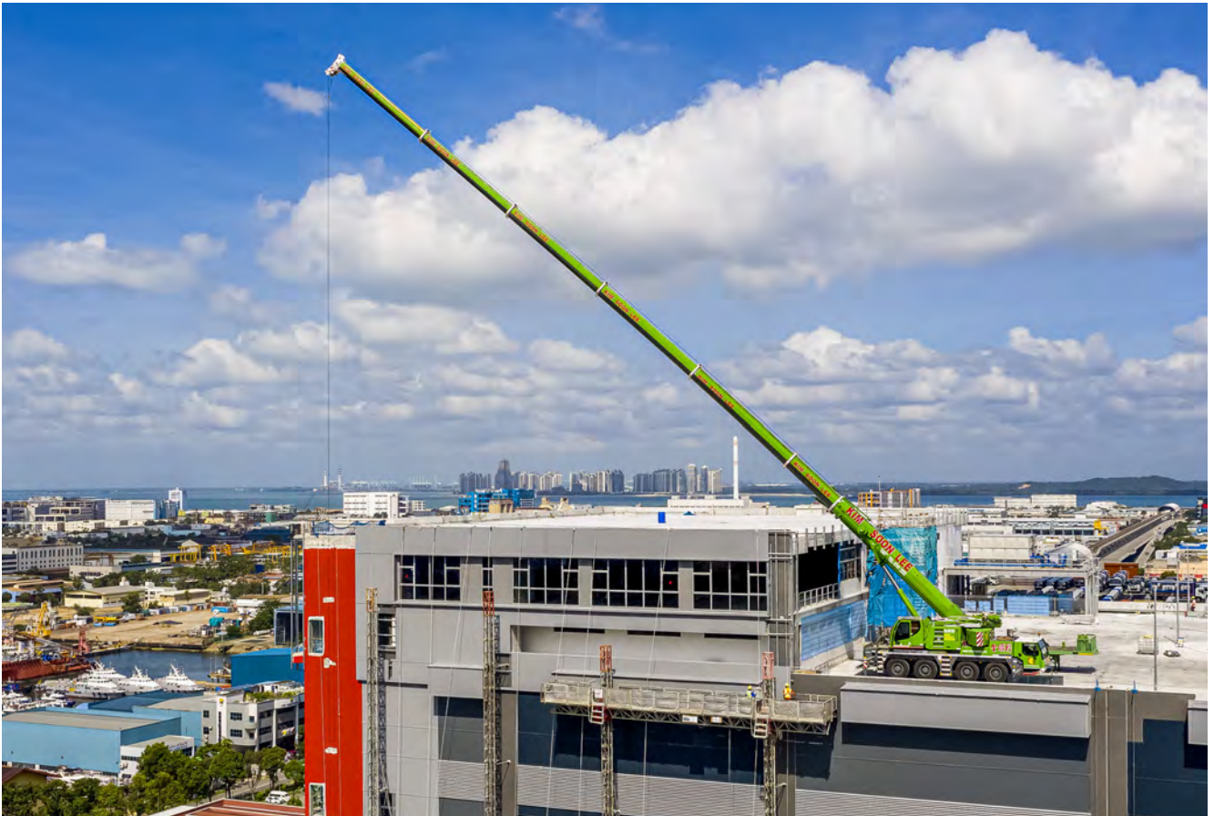
Aussicht pur: Ein LTM 1100-4.2 steht für die Montage einer Außentreppe auf dem Flachdach des Gebäudes. Der grüne Kran gehört dem Unternehmen Kim Soon Lee.
