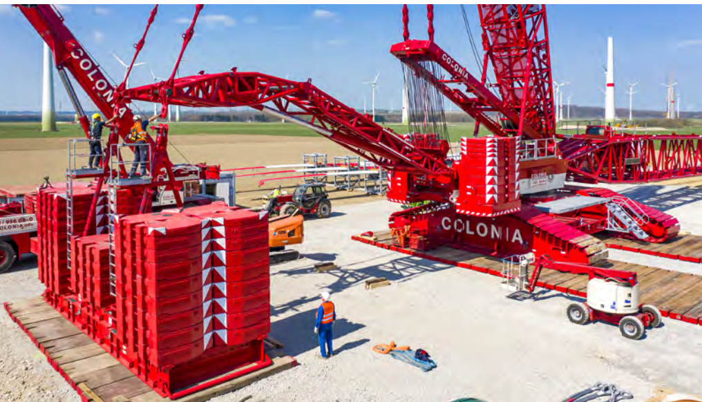
Schweres Kaliber: 400 Tonnen Schwebeballast werden an den Klapprahmen namens „V-Frame“ gehängt.
