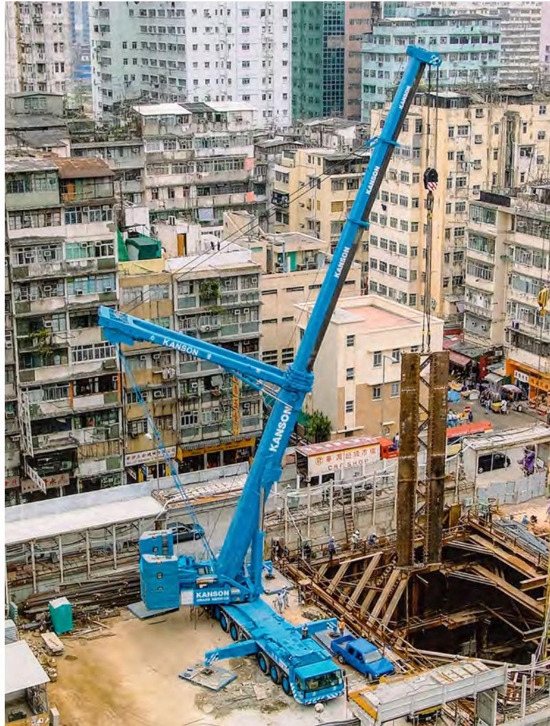
LTM 1500-8.1 mit klassischer TA-Abspannung in Hong Kong
