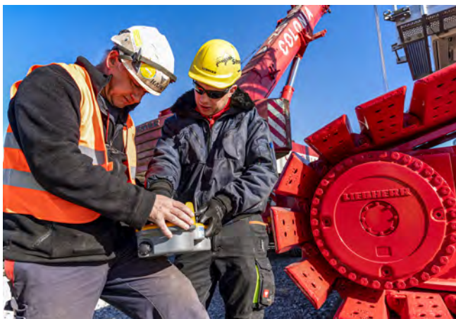
Support aus Ehingen: Steffen Kiem, Mitarbeiter der Raupenkran-Abnahme in Ehingen, unterstützt vor Ort die Rüstarbeiten.
