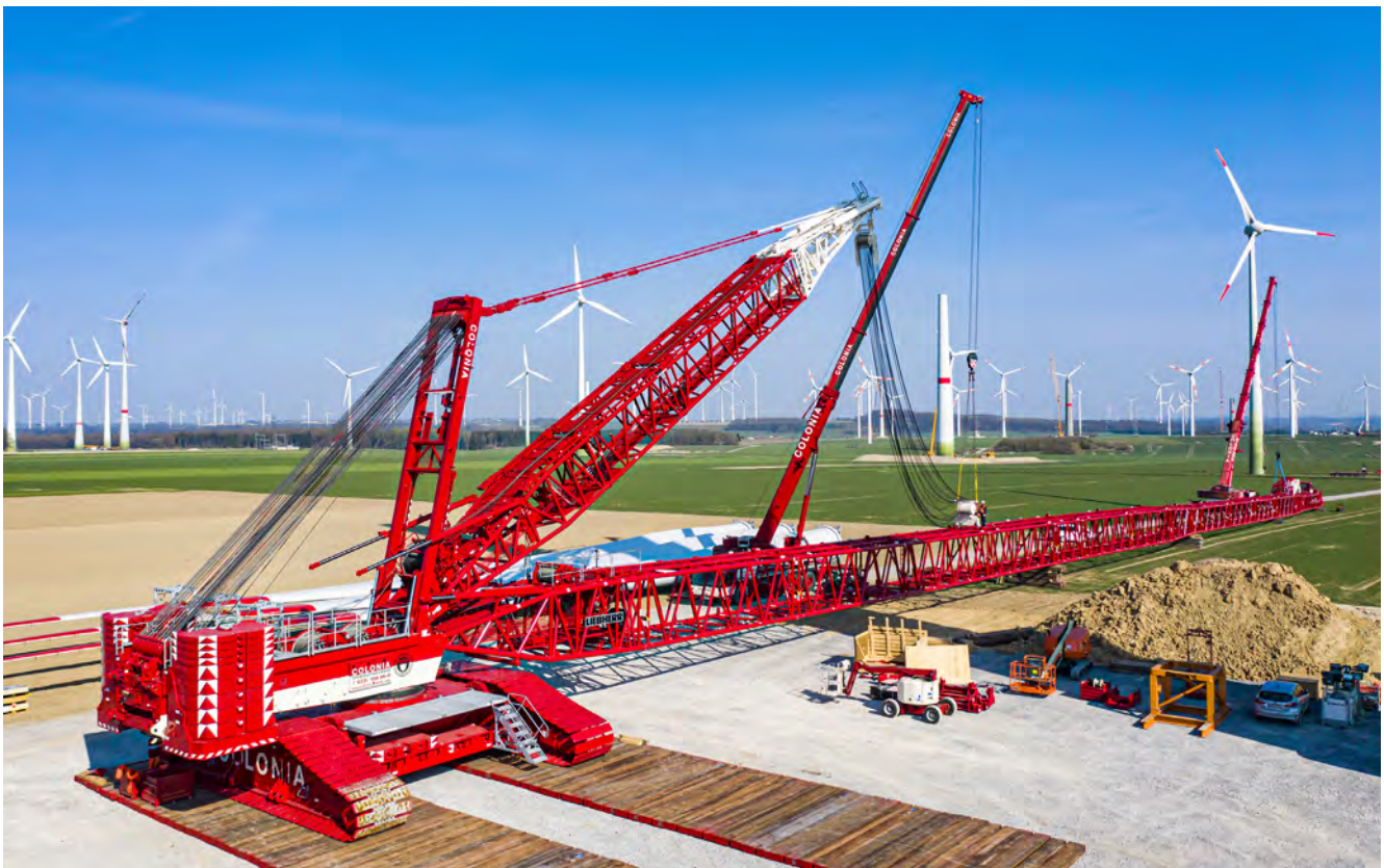
Zwei Liebherr-Mobilkrane wurden für die Rüstarbeiten eingesetzt. Hier wird gerade die Verstellflasche der Derrickabspannung positioniert, rechts im Hintergrund der Hauptmast zusammengebaut.
