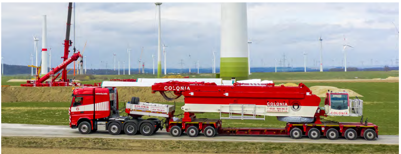
Slim Line: Die Grundmaschine ist auf ein Maß von nur drei Meter Transportbreite konstruiert. Hier trifft der Oberwagen des neuen LR 1800-1.0 von Colonia Spezialfahrzeuge auf der Baustelle im Windpark ein.
