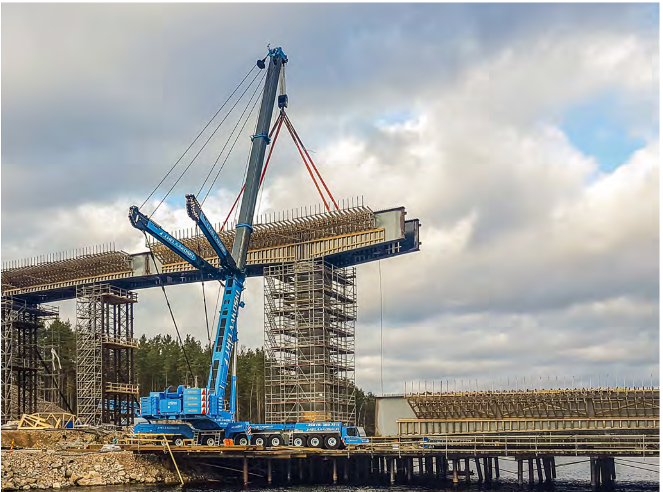
Brückenbau in Finnland: Auch der „neue“ LTM 1750-9.1 von Helaakoski stammt aus dem Liebherr-Pool der Gebrauchtgeräte. Seit wenigen Monaten ist der frisch lackierte 9-Achser im Einsatz – und übrigens der stärkste Mobilkran im Land.
