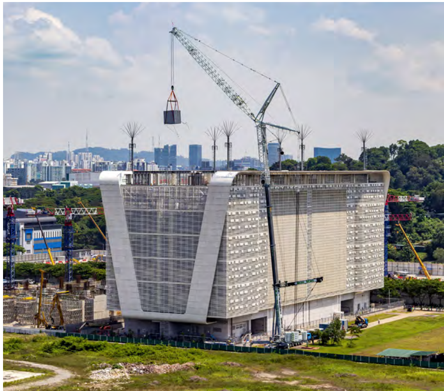
Moderne Metropole: Der LTM 1750-9.1 von Moh Seng Cranes setzt Klimageräte auf einen Industriebau.
