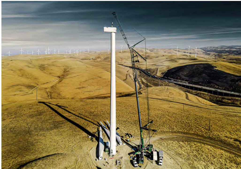
Das 800t-Upgrade machte den Einsatz des LTM 1750-9.1 in einem Windpark in Kalifornien möglich.
