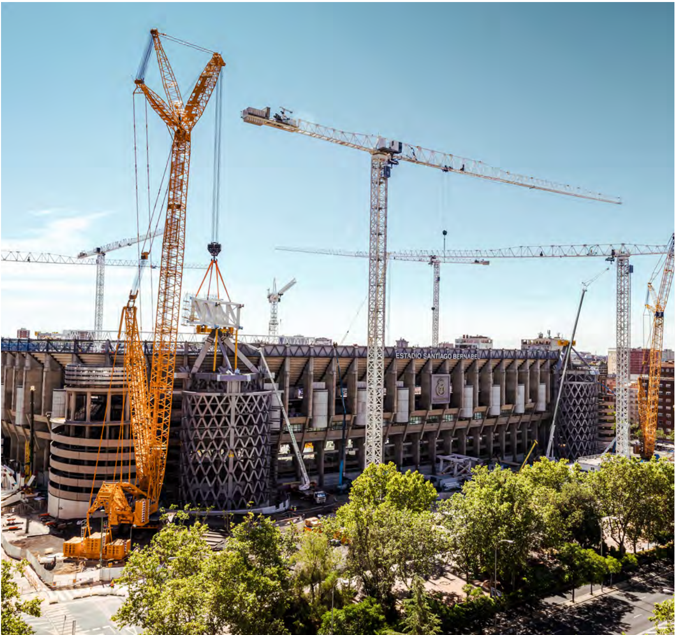
Spielmacher: Der LR 1800-1.0 von Eurogruas mit ersten Segmenten des Dachträgers am Haken.
