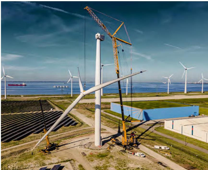
Rückbau einer Windkraftanlage in den Niederlanden.
