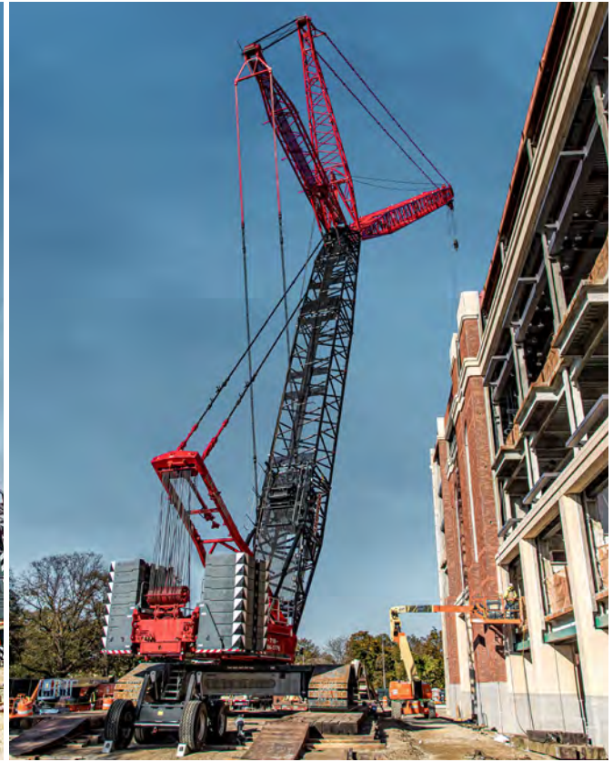
Aufgrund des JFK International Airport darf der Hauptausleger des LR 1500 nicht höher als 73 m sein.
