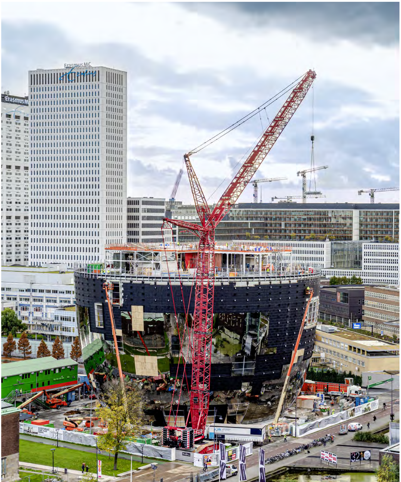
Futuristisch: Der Liebherr-Raupenkran LR 1500 von Mammoet kommt beim Bau eines modernen Kunstdepots für ein Museum im Zentrum Rotterdams zum Einsatz.
