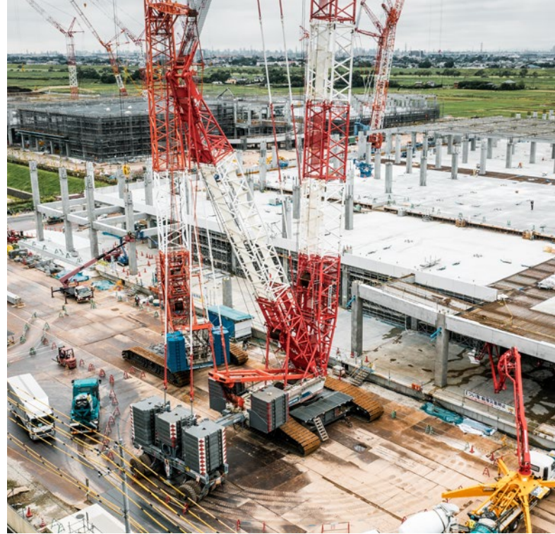
Schnelles Umsetzen der Krane auf der Baustelle dank Ballastwagen
