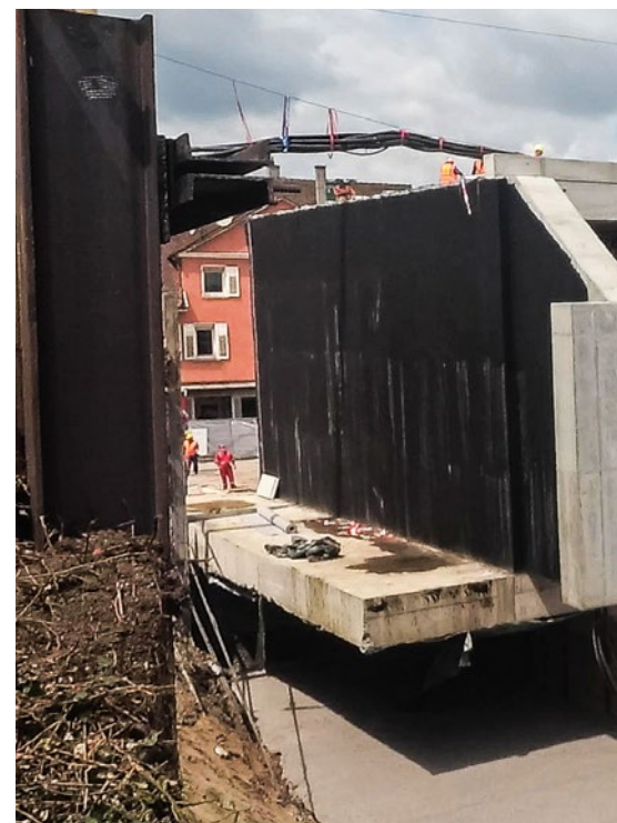
PLT auf SPMT verschieben beim Ersteintritt vorgefertigte, bis zu 1.850 Tonnen schwere Brückenteile zur Endposition.
