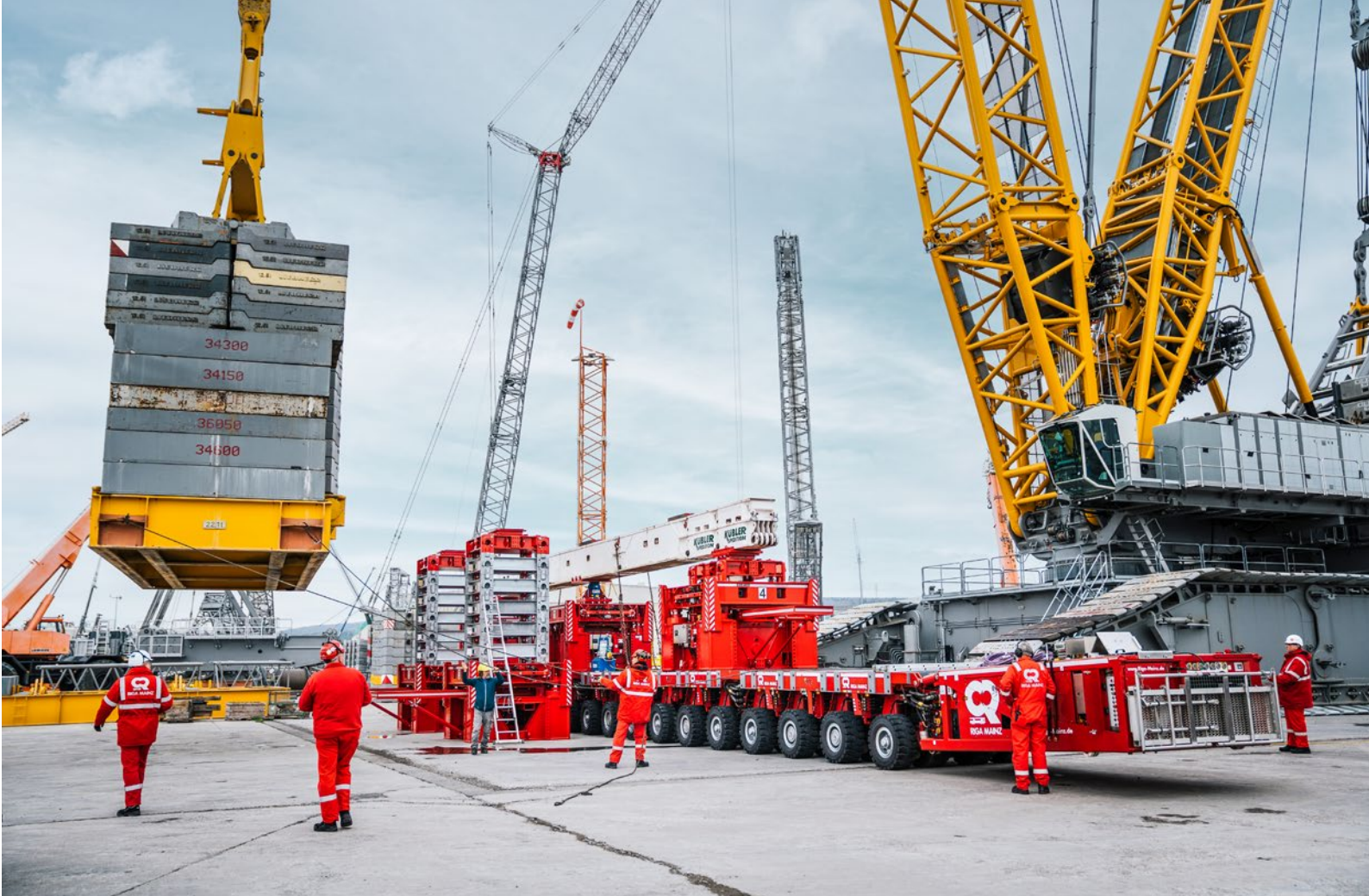
Fünf Power Lift Tower und ein 22-achsiges SPMT sind bereit für einen statischen Belastungstest.
