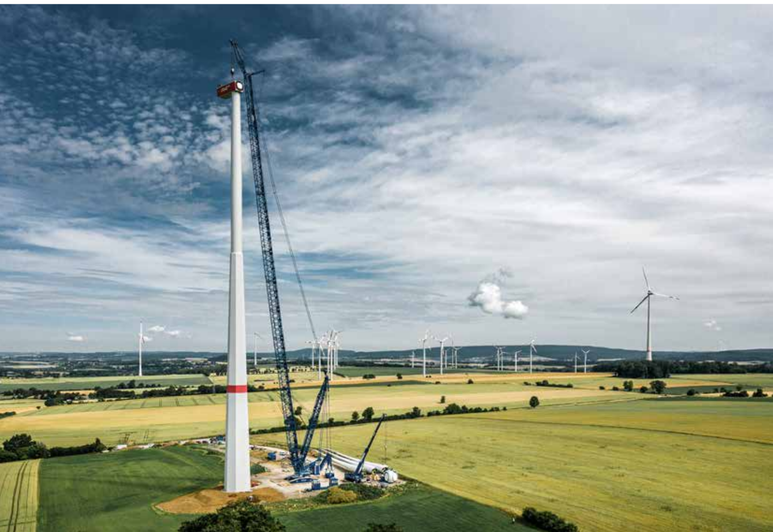
Größere Anlagen erfordern größere Krane und neue Technologien. Hier entwickelt Liebherr gemeinsam mit Kunden Hochleistungstechnologien für die Errichtung von Windkraftanlagen der Zukunft.
