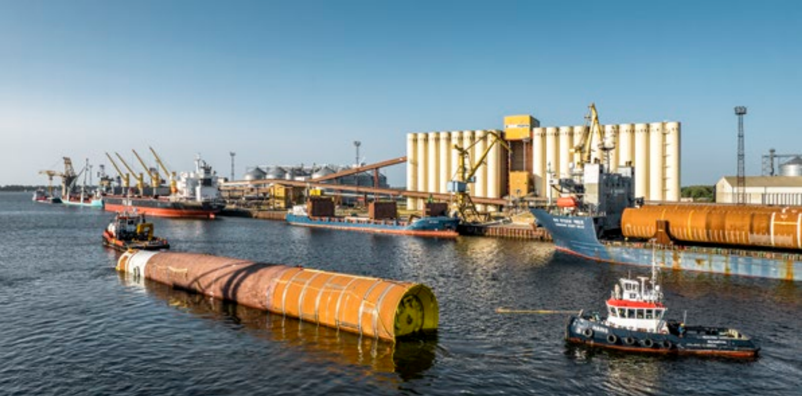
Los geht's! Ein Schleppkahn zieht den schwimmenden Monopile in die Ostsee. 15 Stunden dauert die rund 160 Kilometer lange Reise bis zur Offshore-Baustelle.
