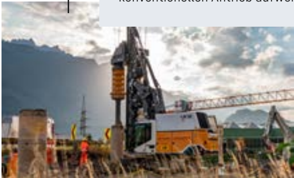
Leiser Riese auf der Baustelle: Mit dem LB 16 unplugged schlägt Liebherr ein neues Kapitel auf.
